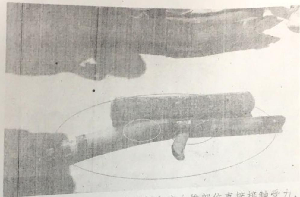
5. 如下图红圈所示，绝缘挡板和应力锥部位直接接触受力，如蓝圈所示，电缆接地线在柜体过渡接地，未直接和主网接地，如绿圈所示，应力锥位置弯曲，长期运行会造成密封部位泄露。
