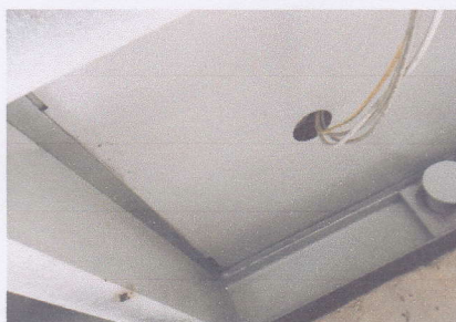
15、箱逆变下通讯电缆随意撒落地上
