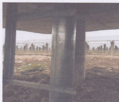
16、箱逆变平台下高压电缆钢套管与支架未设抱箍固定
