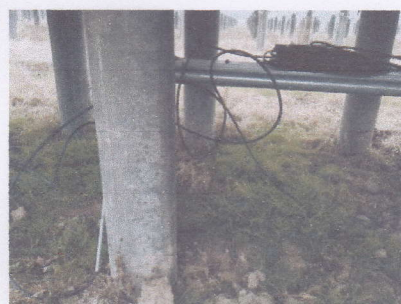
16、箱逆变平台下高压电缆钢套管与支架未设抱箍固定
