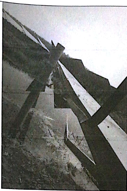
1#塘更换桥架后接地未连接
