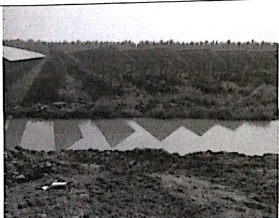
22#塘西侧环沟宽度不足
