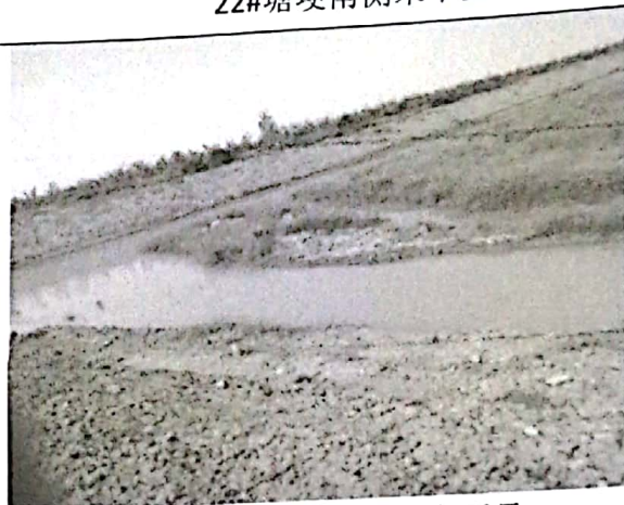
21#塘东侧环沟宽度不足
