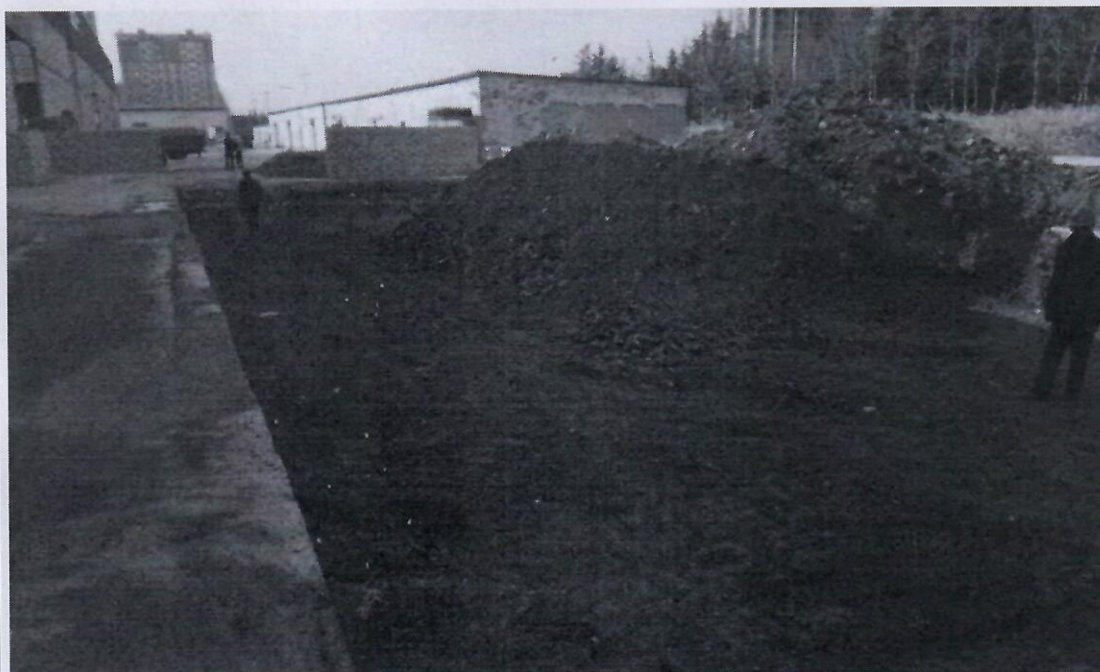
施工现场应采取临边防护措施。(图 2)
