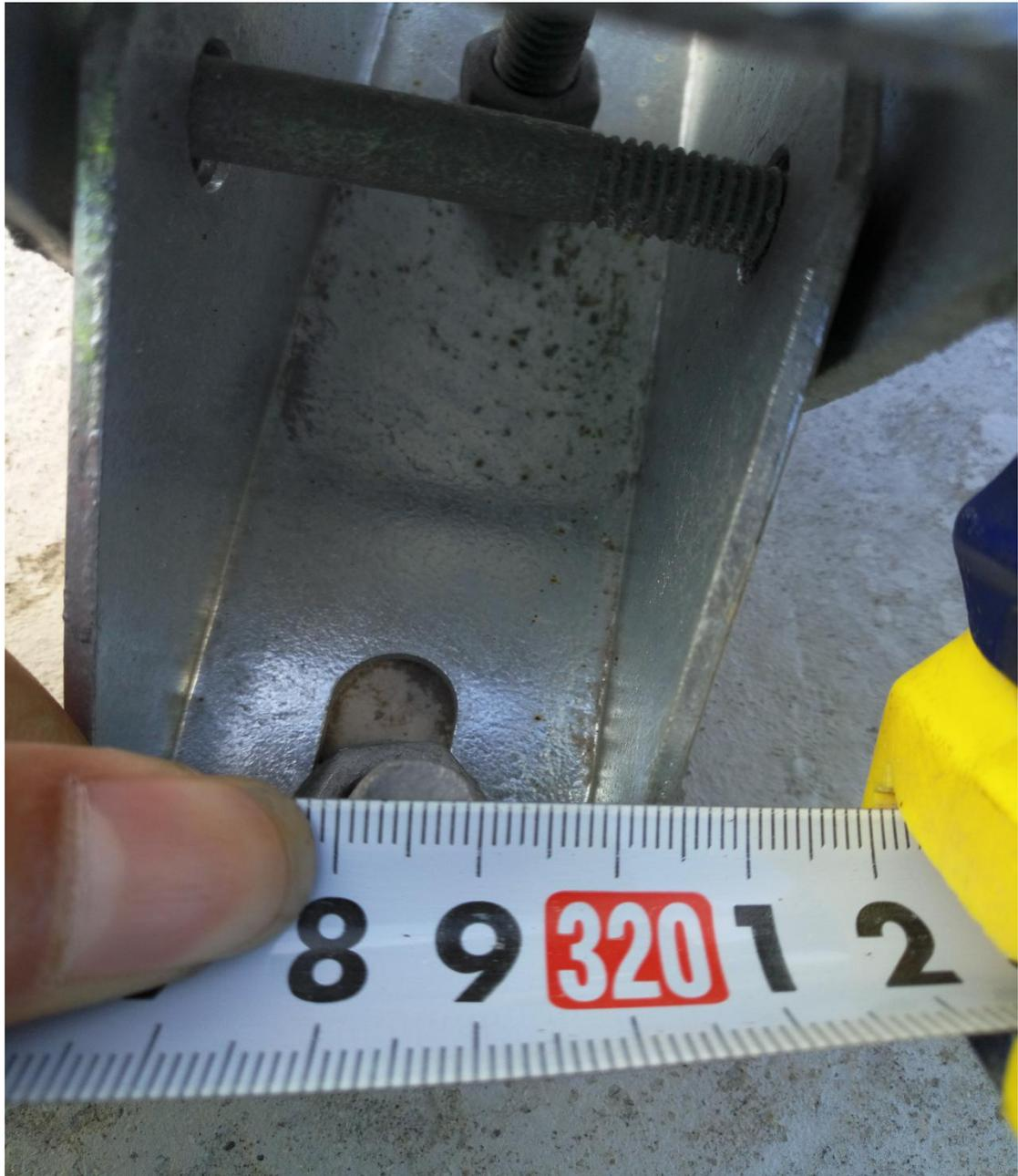
现场实际测量 U 型螺栓为 M10 不符合设计图纸 M12 要求。
