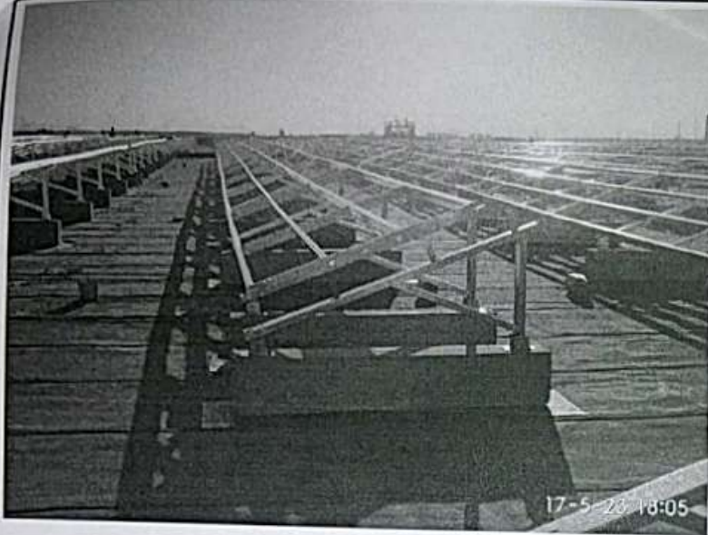
3、加工车间屋顶防水卷材被破坏。
