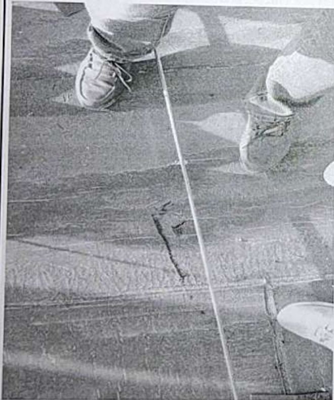
3、加工车间屋顶防水卷材被破坏。
