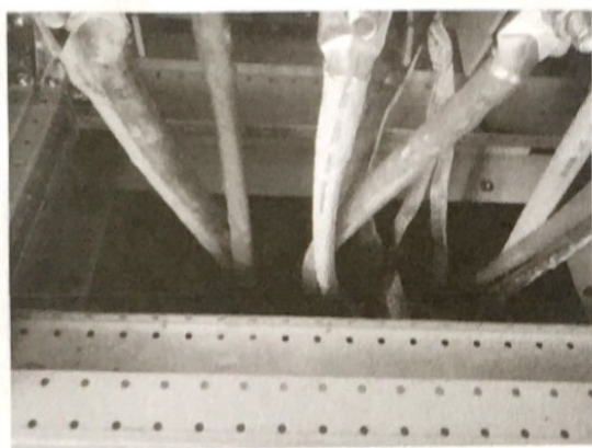
3. 所有箱变低压侧接线处盖板、夹具均未安装
