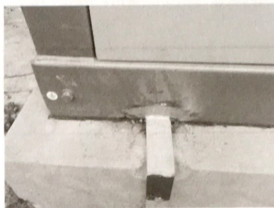
6. 10#箱变低压侧电缆头套管破损
