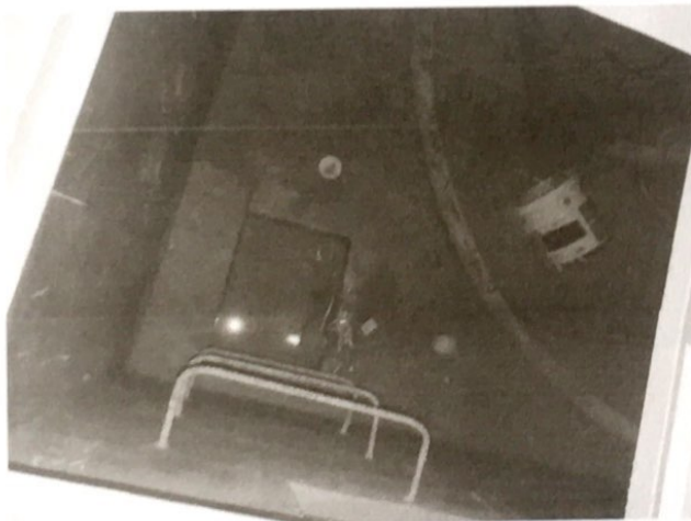
7. 部分区域组件下电缆未吊起
