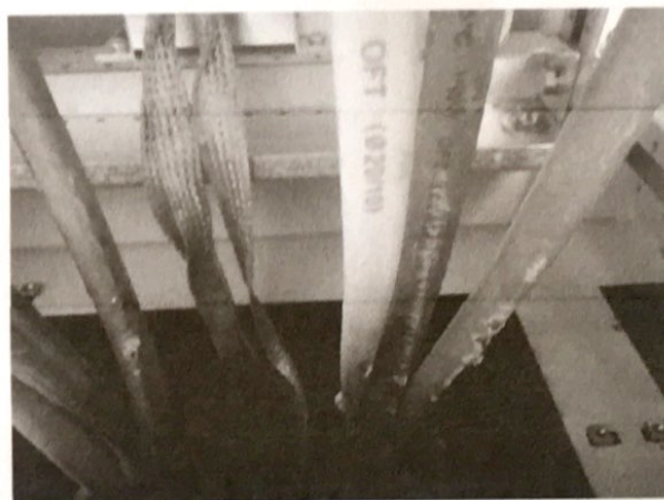
8. MC4 接头及过道电缆外漏, 未作穿管保护措施
