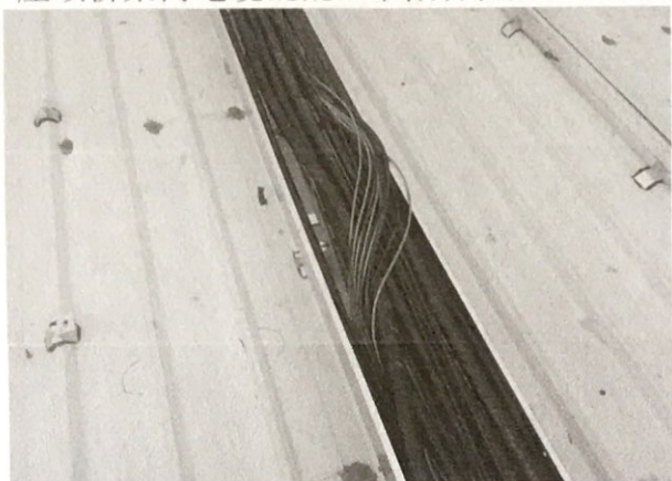
11. 接地扁铁未焊接，未引至楼下接地点
