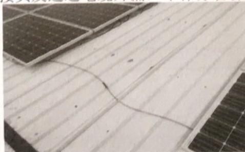
8. MC4 接头及过道电缆外漏, 未作穿管保护措施
