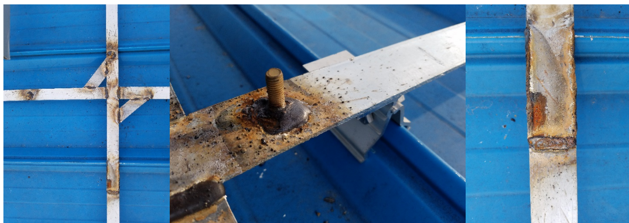
焊接处及时做防腐处理
