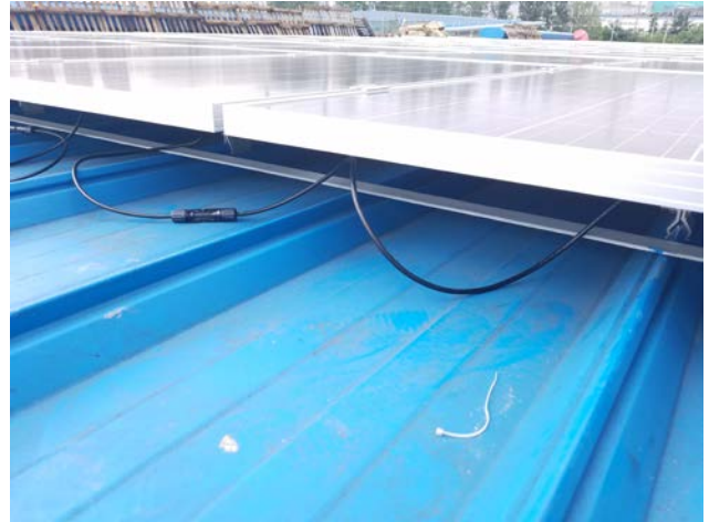
光伏线应绑扎在导轨上
