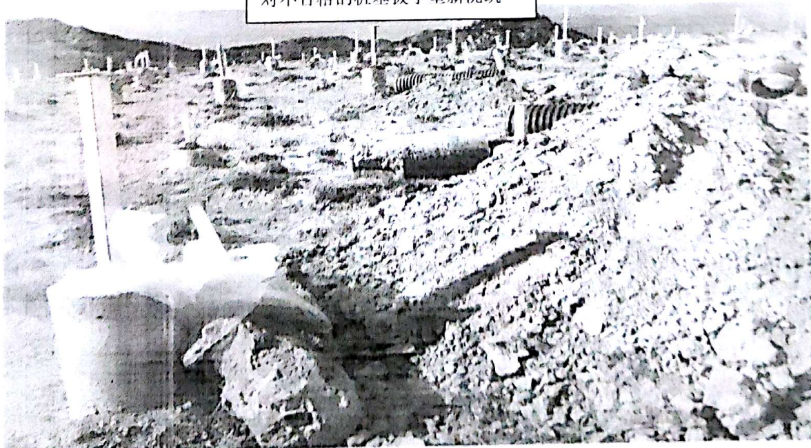
对不合格的桩基拔了重新浇筑
