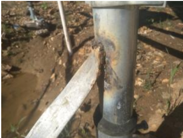
接地扁铁焊接区过短、焊接前焊渣未清理
