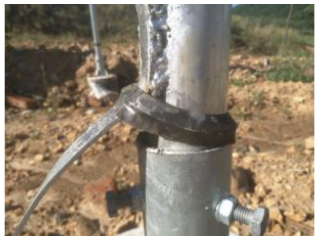
组件板面上有划痕、防水皮套安装位置错误
