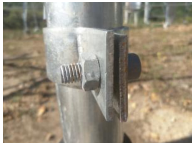
立柱上抱箍的螺母未使用热镀锌已生锈、未加垫片和弹垫
