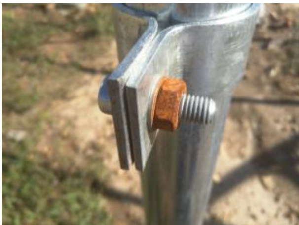
立柱上抱箍的螺母未使用热镀锌已生锈、未加垫片和弹垫
