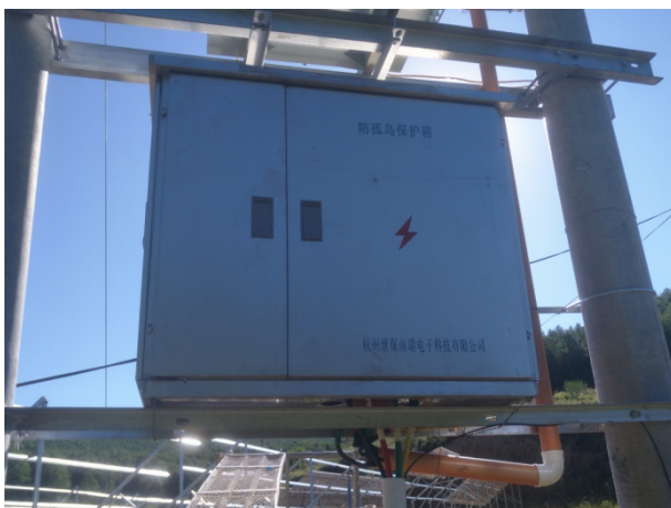
防孤岛箱下洞口未封堵，接线混乱
