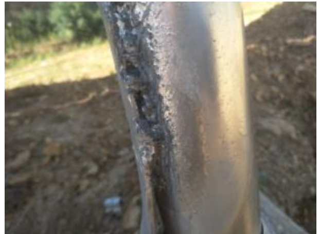
接地扁铁焊接区过短、焊接前焊渣未清理
