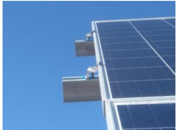
边压块安装不符合要求（未压靠、歪斜）
