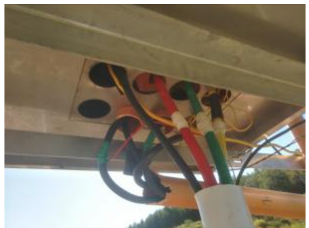
防孤岛箱下洞口未封堵，接线混乱
