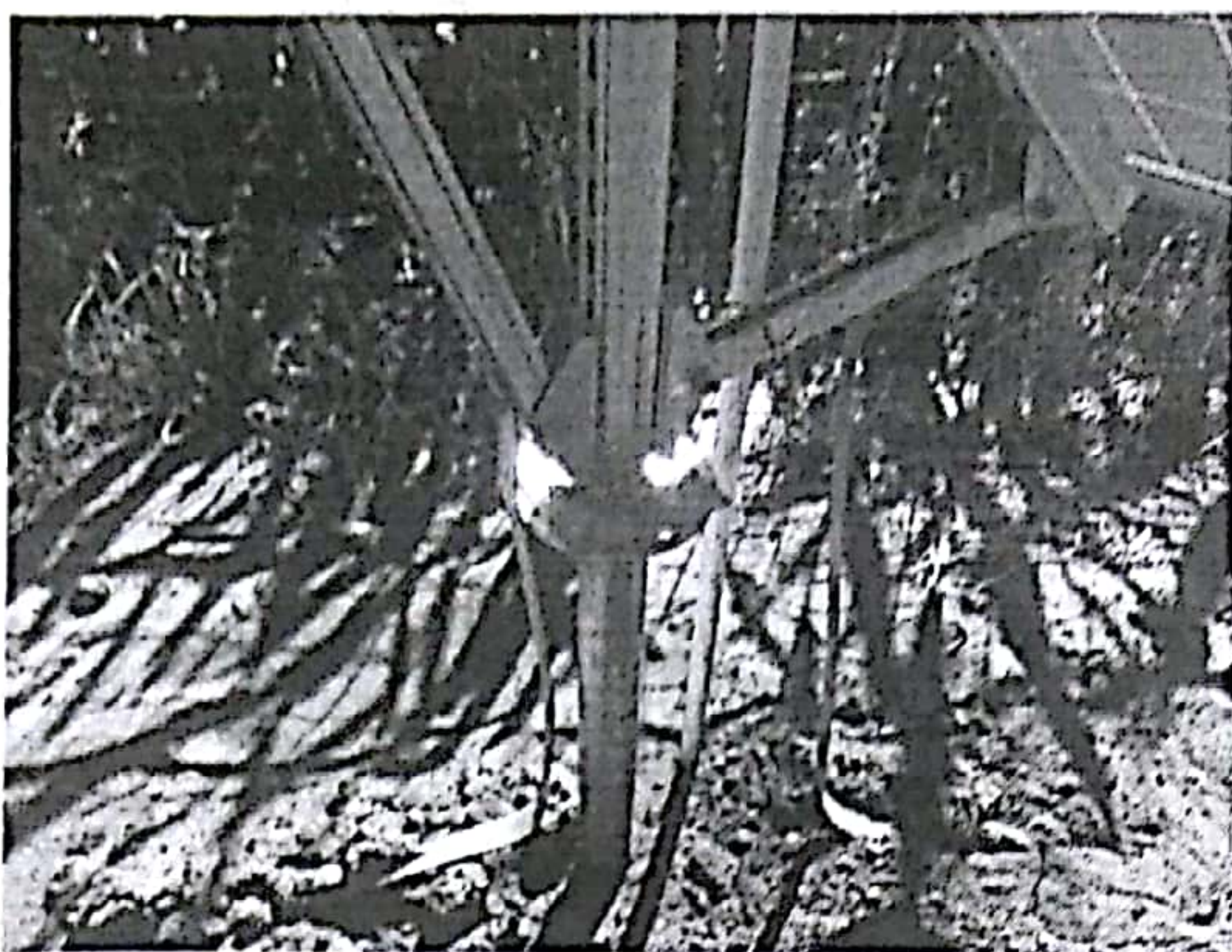
接地扁铁未刷黄绿漆
