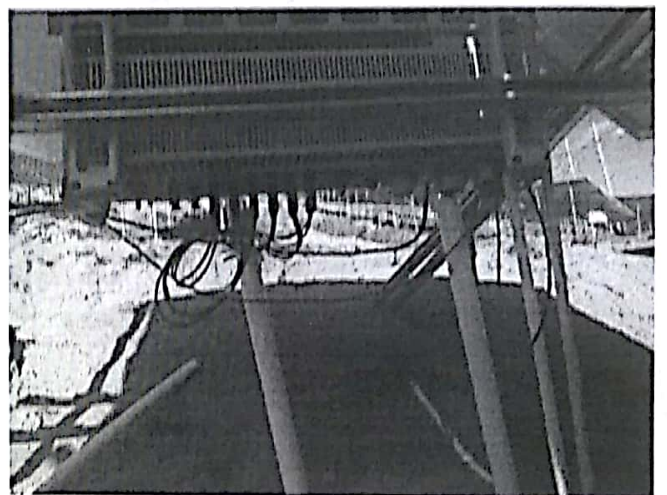
逆变箱体进线套管过短、电缆线混乱不规范
