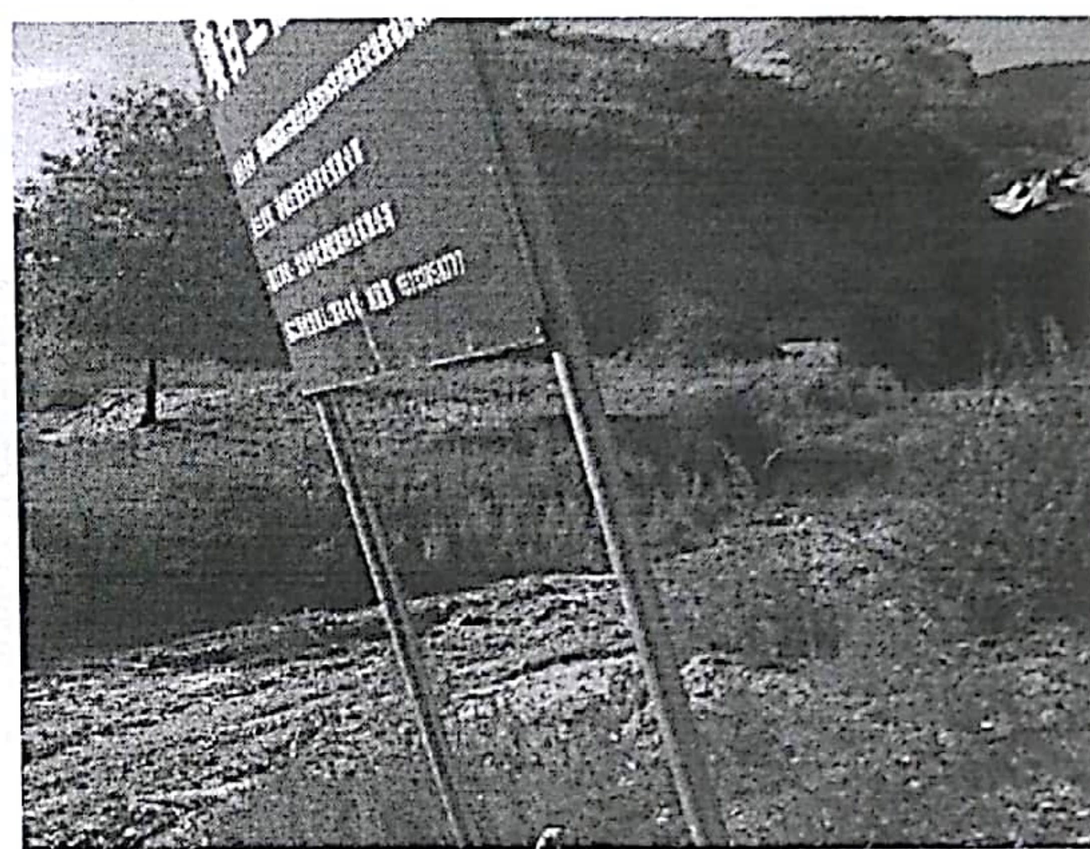
项目工程牌歪斜
