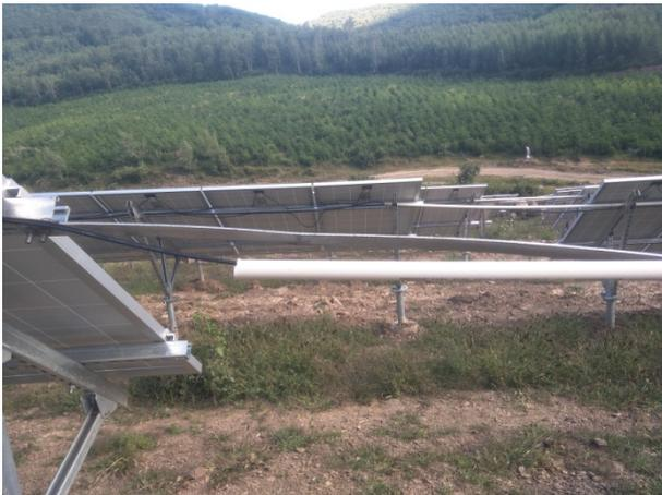
部分组间接线套管偏短未固定
