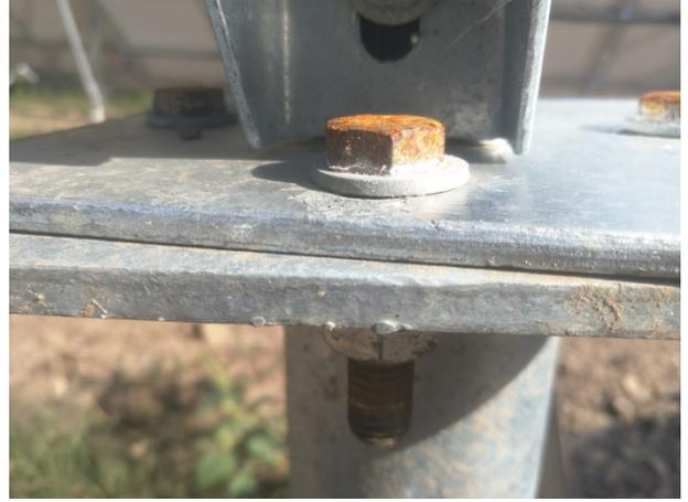
部分螺栓未加弹垫、螺丝生锈
