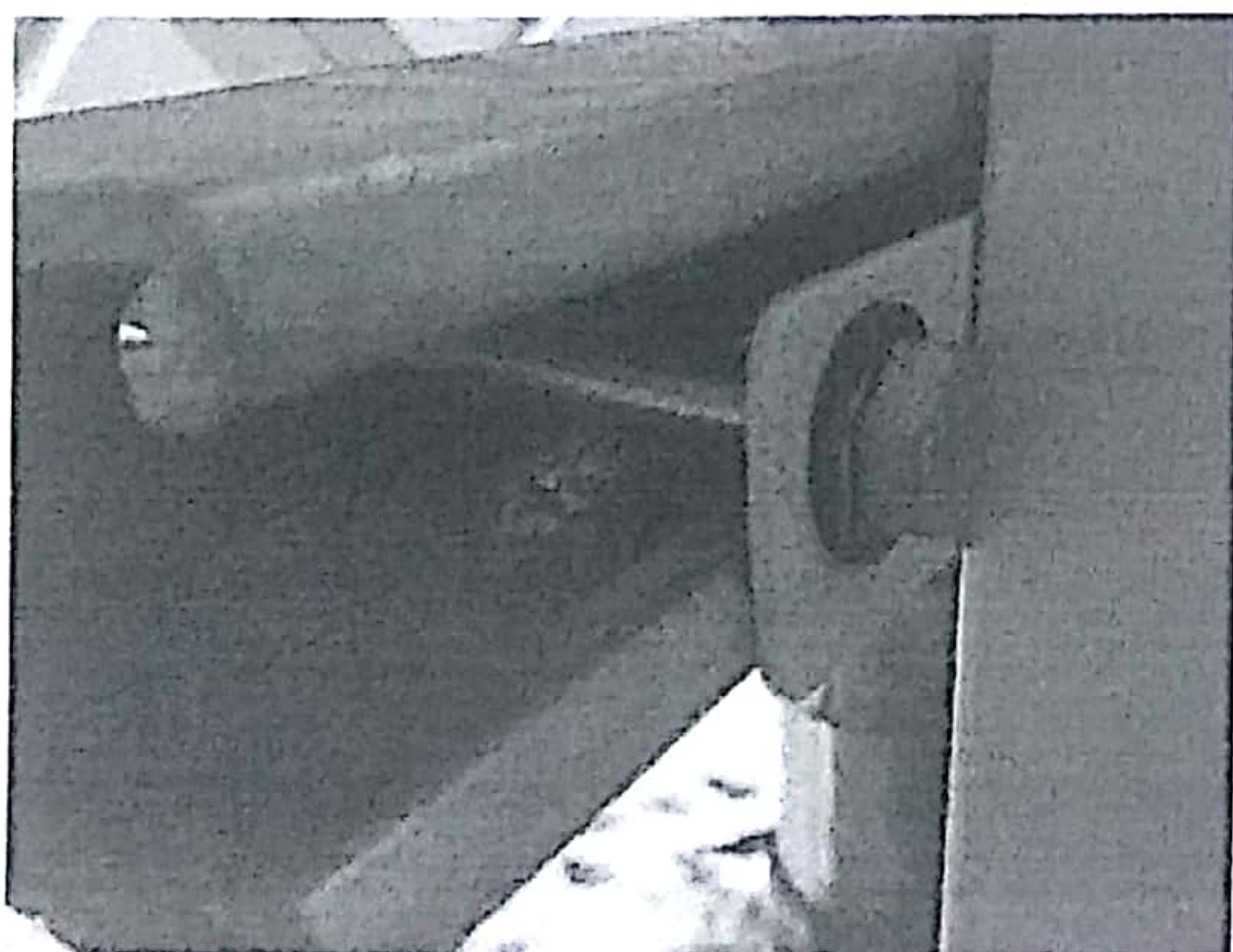
部分垫片螺栓抱箍等材料生锈
