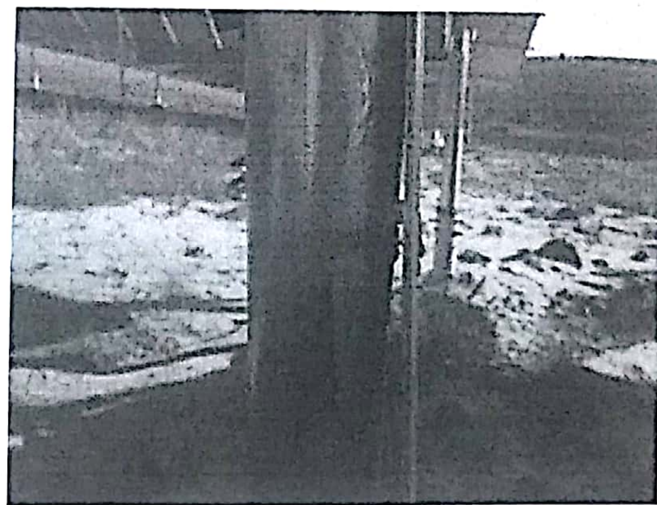
接地扁铁焊接不合格
