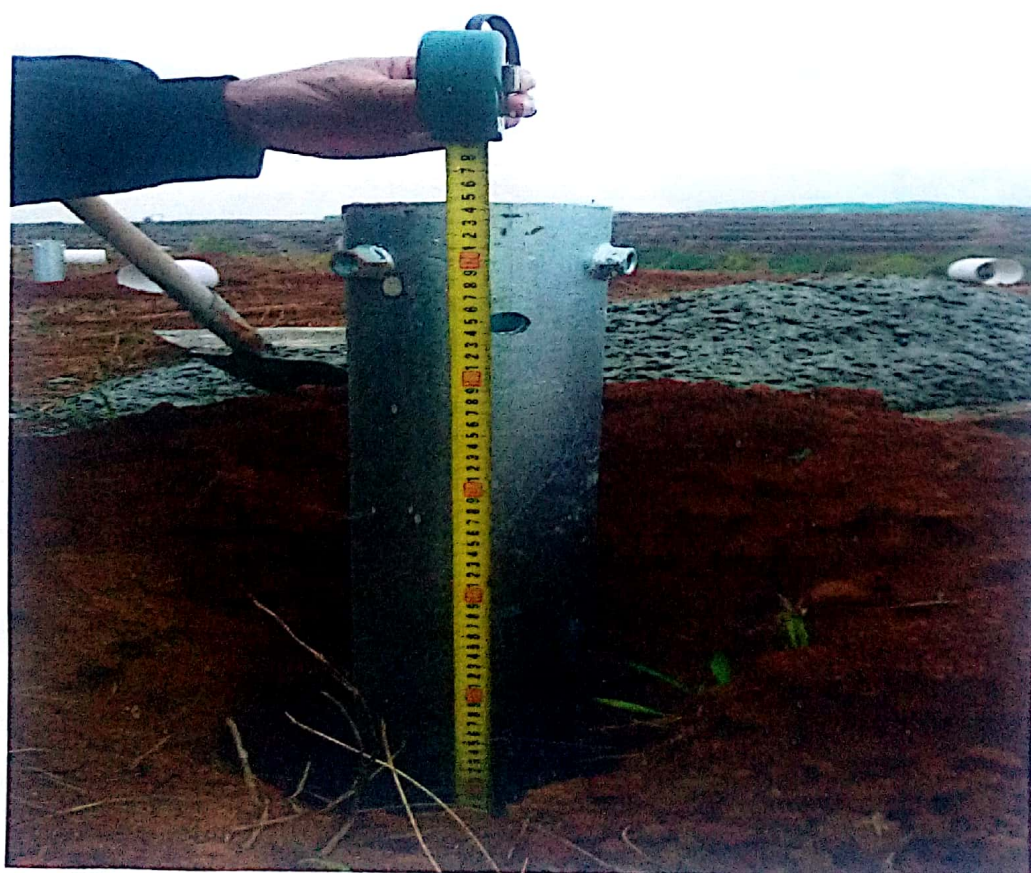
桩基构件总长度为2.2m. 检查深度1.25m. 打入桩层深度0.45m.
