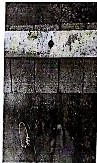
▲灰缝偏小且没有灰缝
