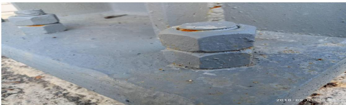
漏焊及焊缝不符合要求
