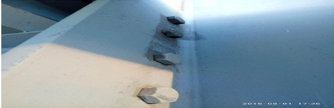
连接钢板缝隙过大
