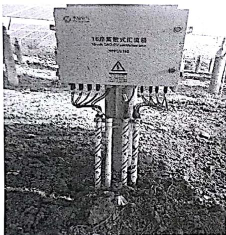
14、立柱间橡皮圈应封至中间接口出。
