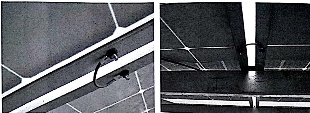
9、檩条斜梁连接件螺丝松散未紧固到位。
