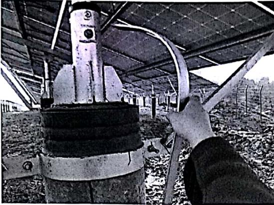
16、接地扁铁焊渣未敲，防腐未做。
