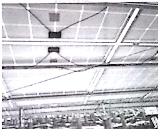
1x4 线缆被固定在拉杆上
