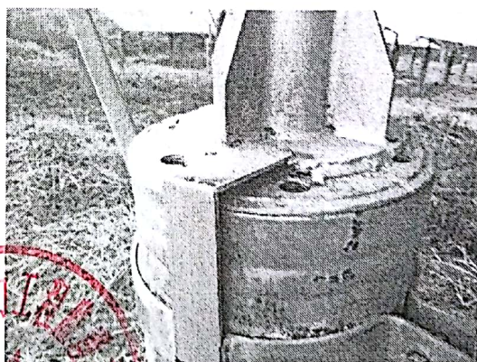
接地扁铁搭接长度偏短
