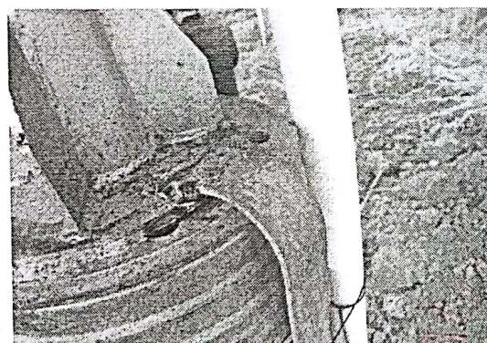
接地扁铁搭接长度偏短
