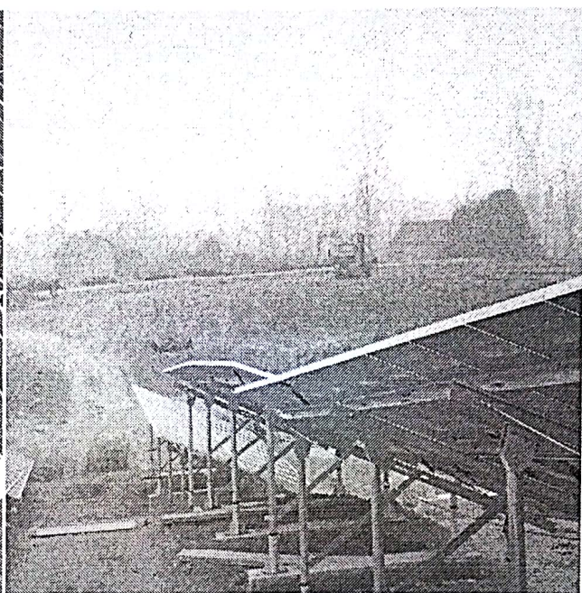
组件安装不在同一水平面
