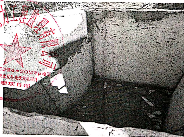
箱变漏油池不符合设计要求
