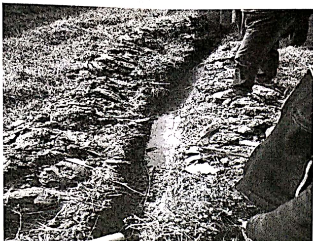
场区电缆沟埋深不符合设计规范要求
