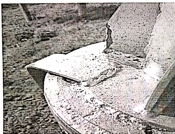
接地扁铁搭接面积不合格
