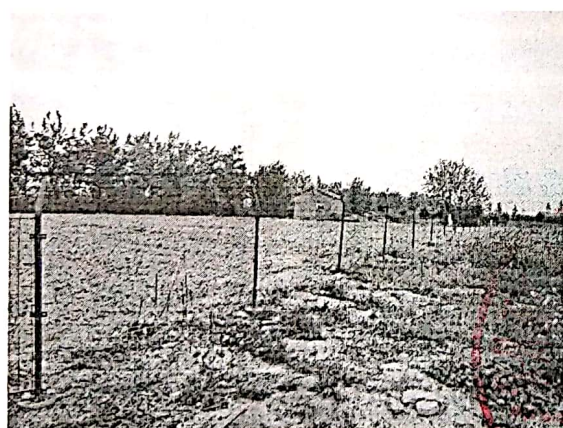
场区围栏安装不到位
