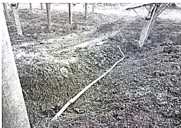
31 区接地扁铁焊接未防腐埋深不合格
