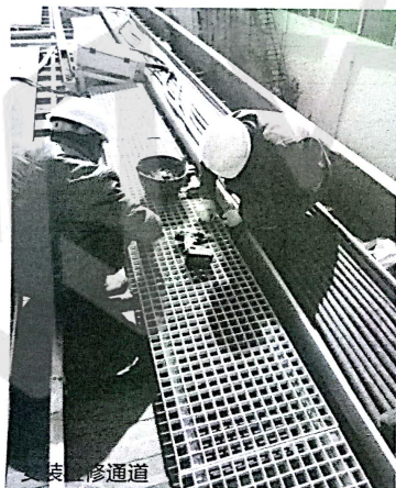
安装检修通道
