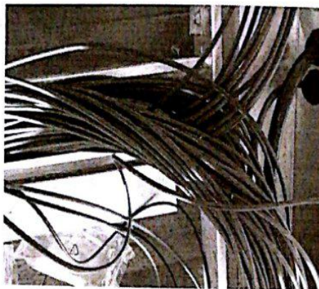
桥架内电缆容量不符合规范要求
