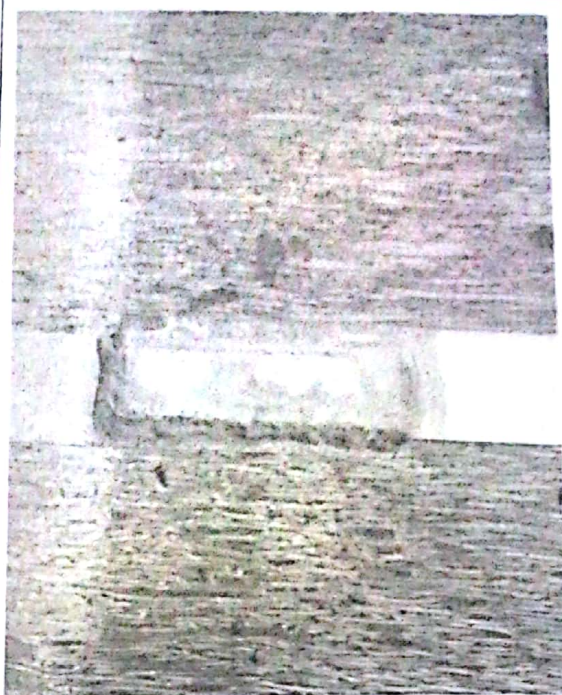
接地扁铁连接处生锈
