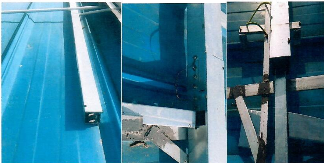
8. 桥架洞口未封堵防火泥。
