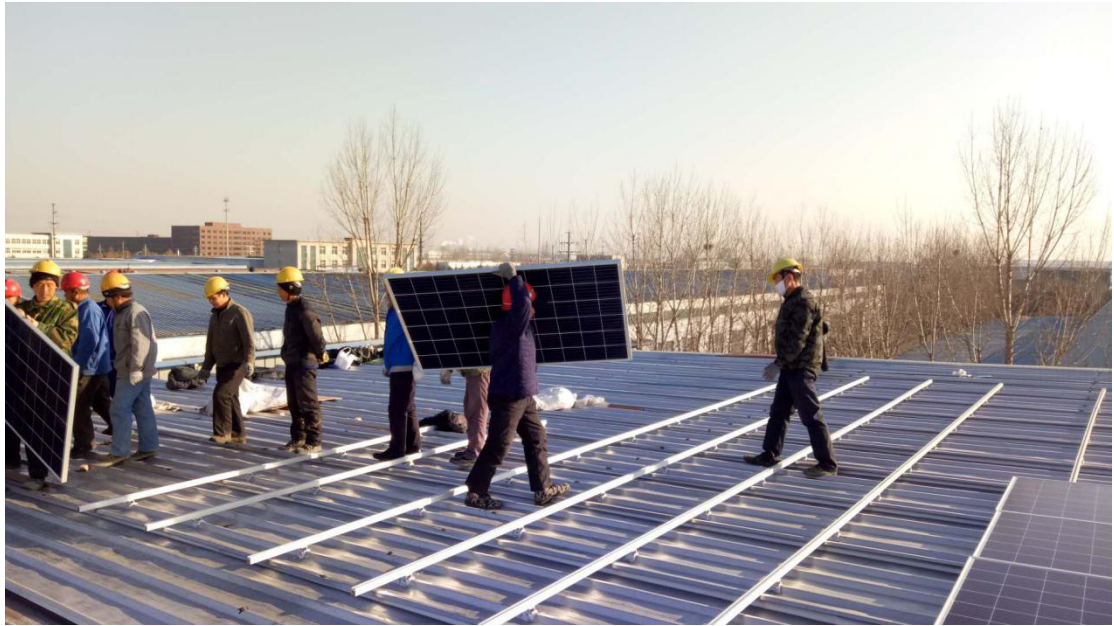
背朝组件玻璃面板搬运 2017. 12. 18
