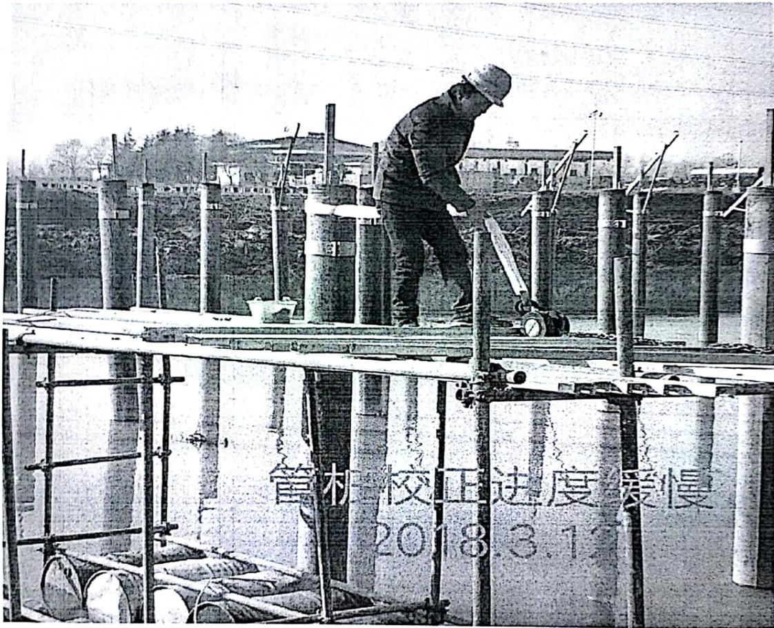
2. 3#、4#区域个别管桩歪斜严重，焊接立柱偏离桩顶中心较大，需校正和整改。
