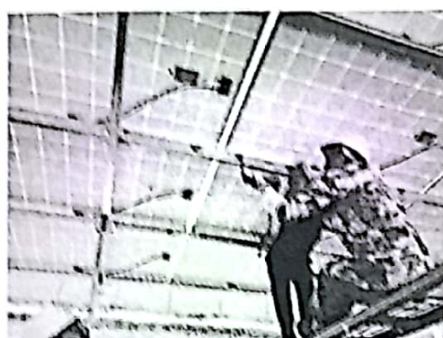
对组件进行安装调整
