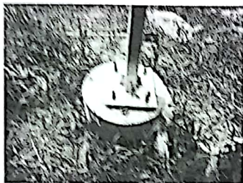
支架底座与支架桩基础之间垫铁块
