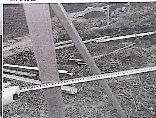
3. 立柱安装已垂直，安装距离已经整改，已达到图纸设计的要求。
