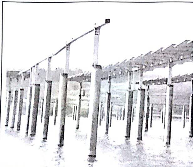
支架安装不平直
