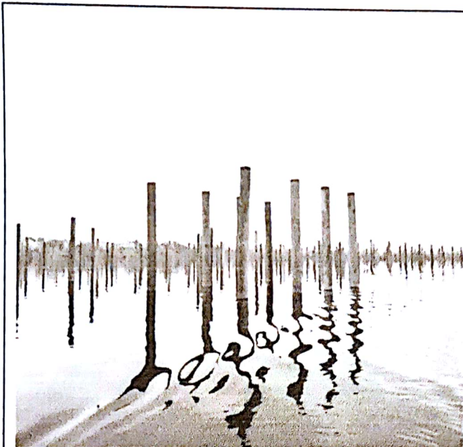
箱逆变基础管桩轴线偏差较大
