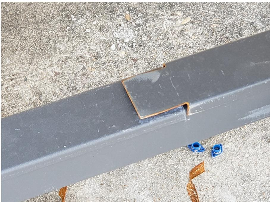
铁屑等残渣以及切割加工区域未及时清理，造成材料进一步锈蚀
