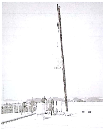
吊装材料悬空
