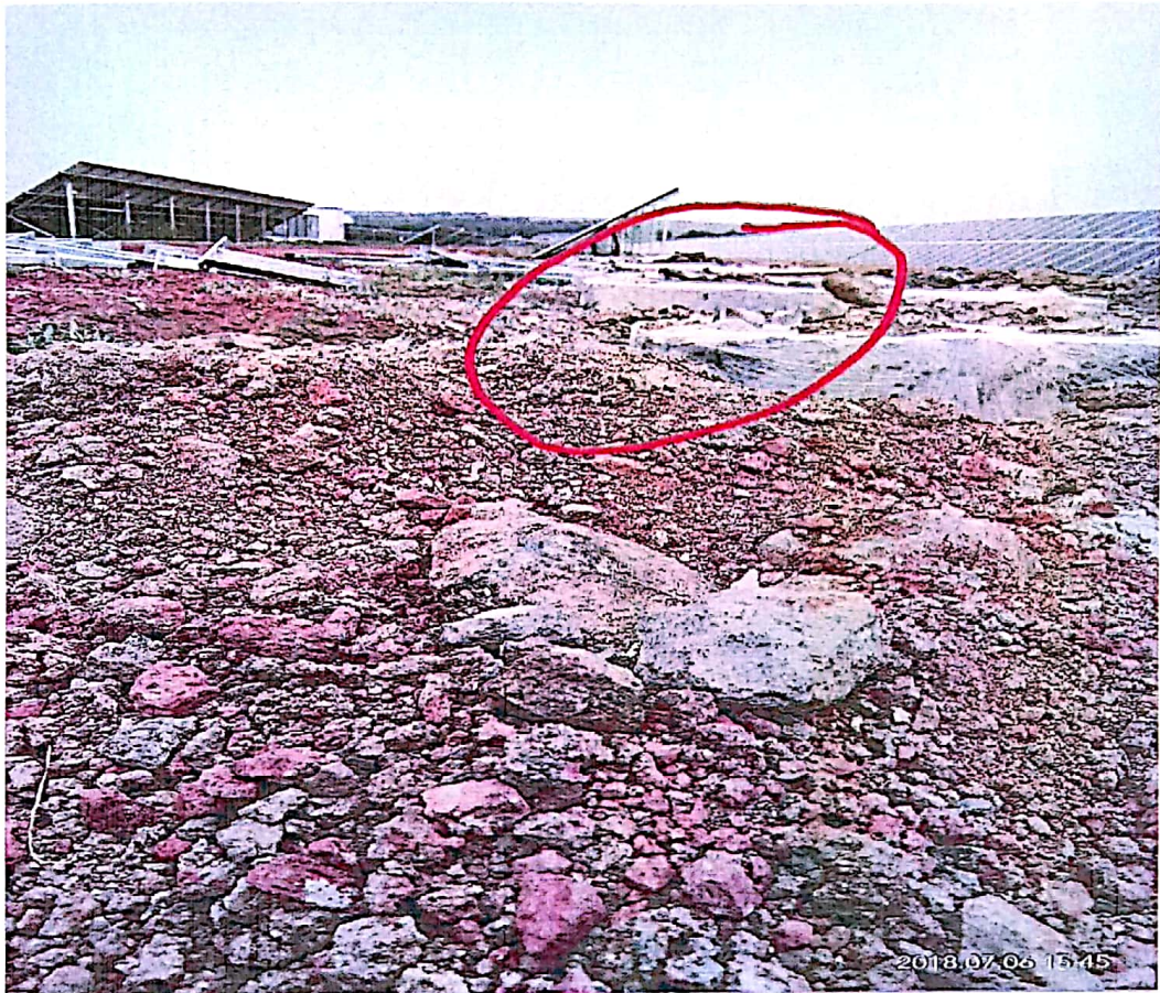
光伏支架安装前前条形支墩情况
