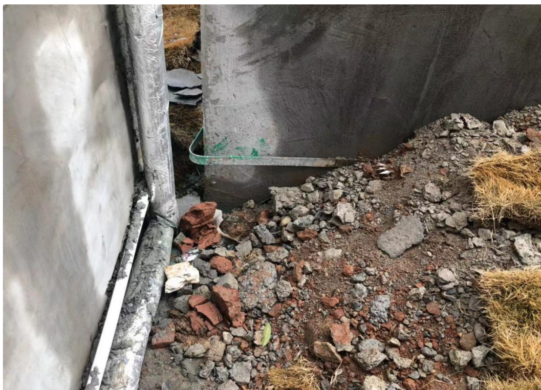
5.各箱变设备防火封堵不到位，且防火 泥 严 重 脱 落
