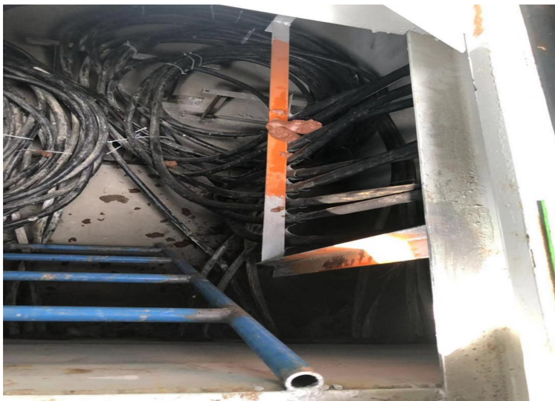
5.各箱变设备防火封堵不到位，且防火 泥 严 重 脱 落
