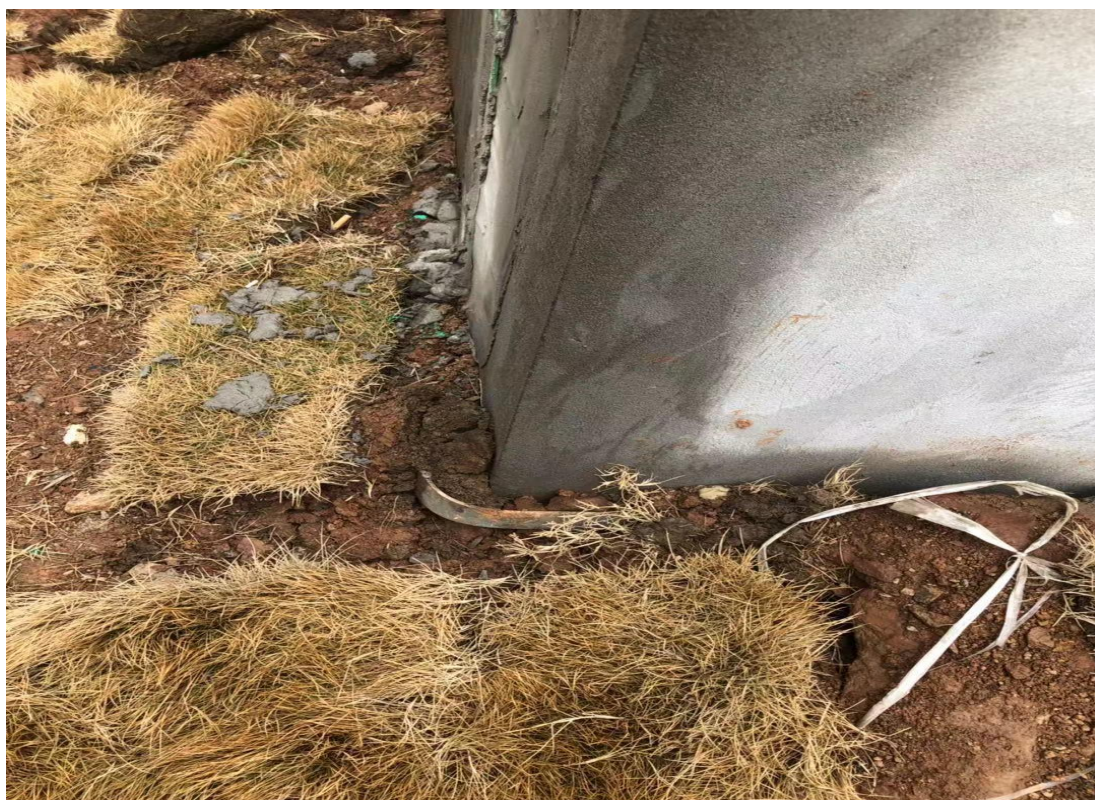
4. 设备基础接地扁铁埋至深度过浅，且 外 露 地 表
