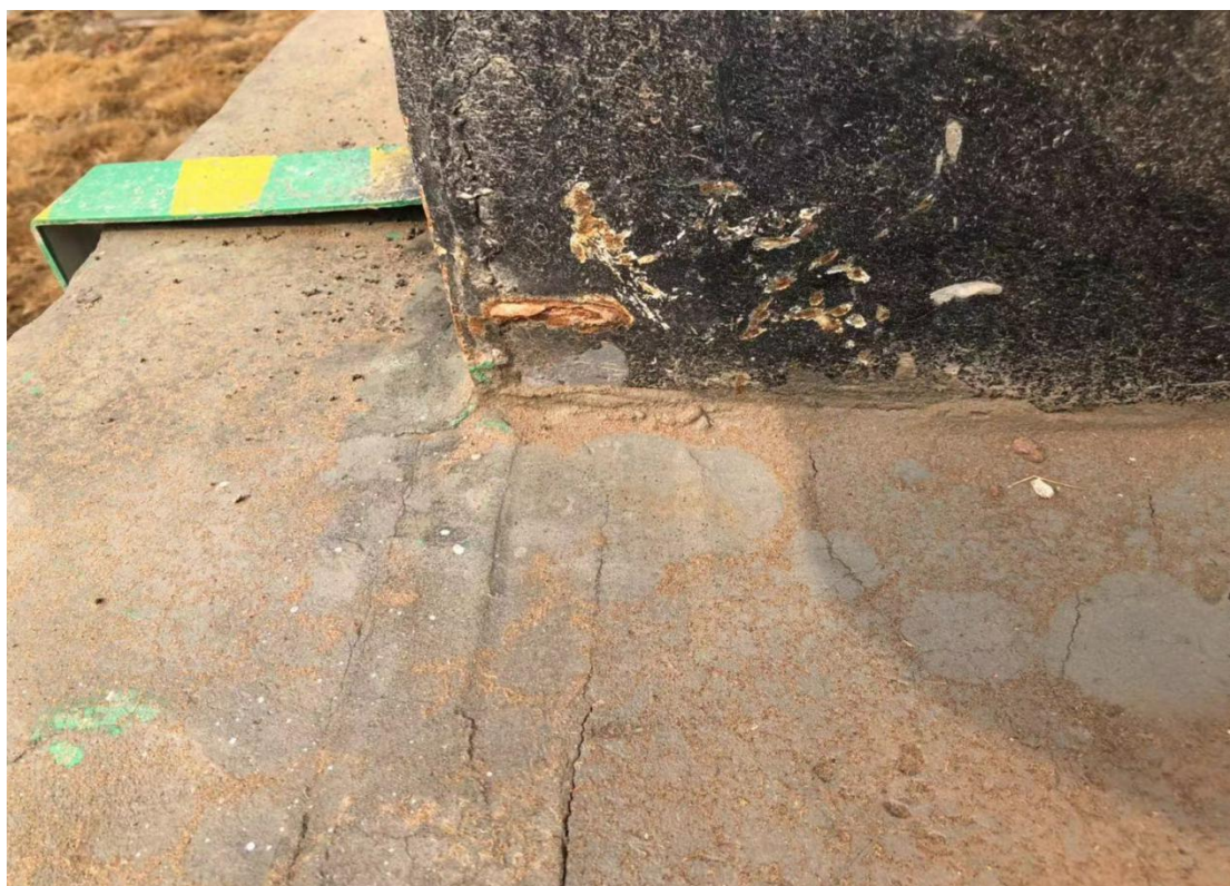
4. 设备基础接地扁铁埋至深度过浅，且 外 露 地 表
