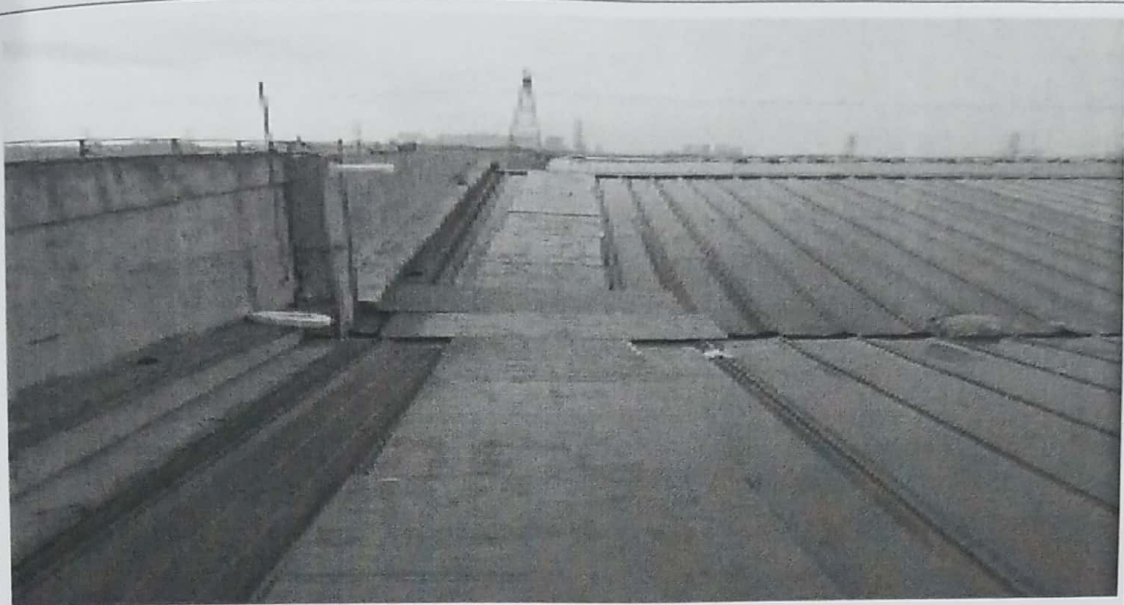
1. 通道木板连接处已进行有效固定
