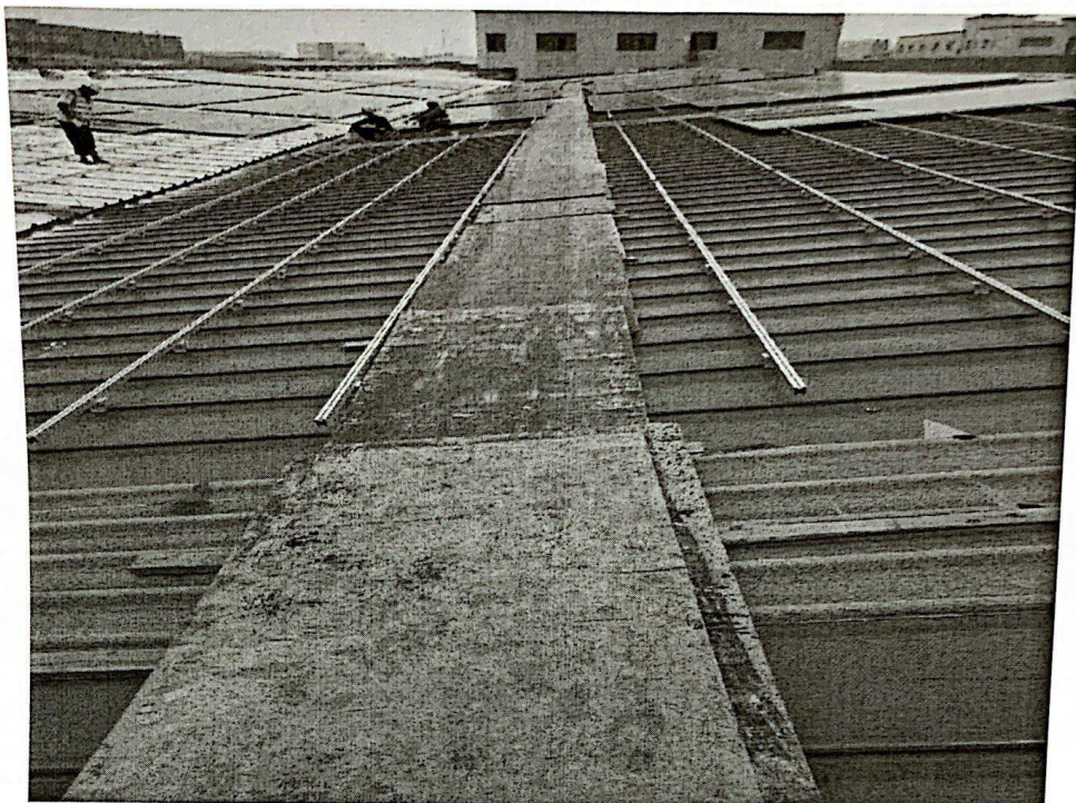
1、施工通道照片
