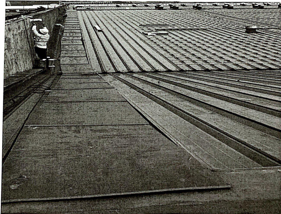
2、临时电线铺设照片
