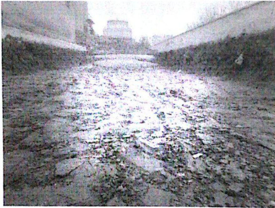
夯实后的基槽
