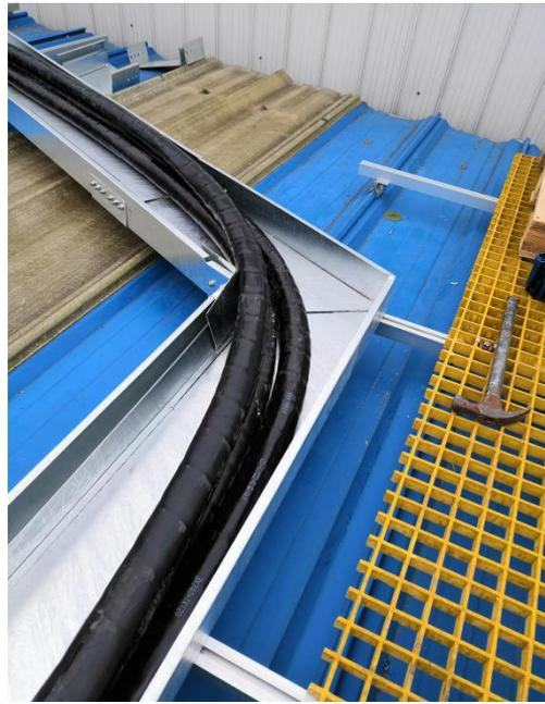
电缆转弯半径不够、桥架转弯处未设置转接头
