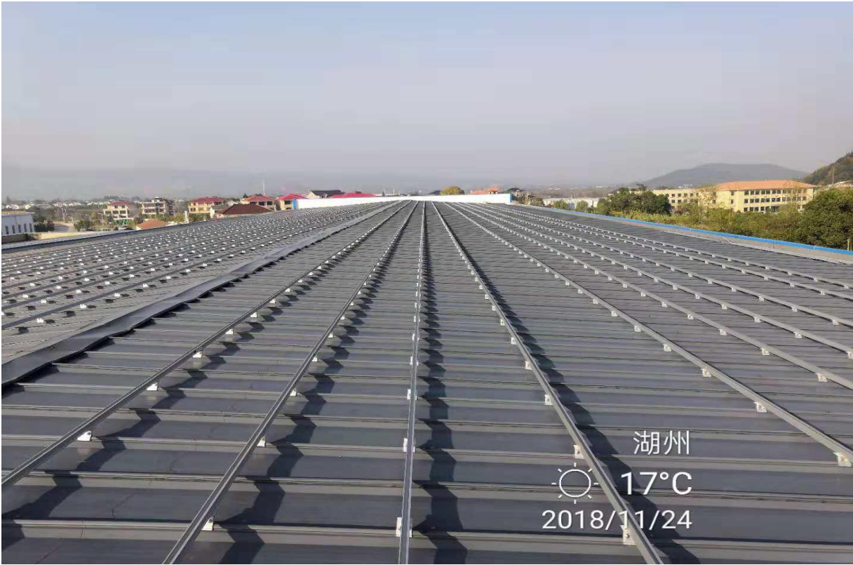
现场实际排布
