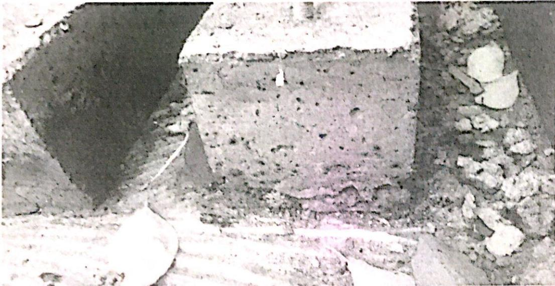
现要求你方浇筑混凝土基础时，严格按照施工规范进行作业，并加大振捣力度，振捣时间，尽快整改有缺陷的基础。
