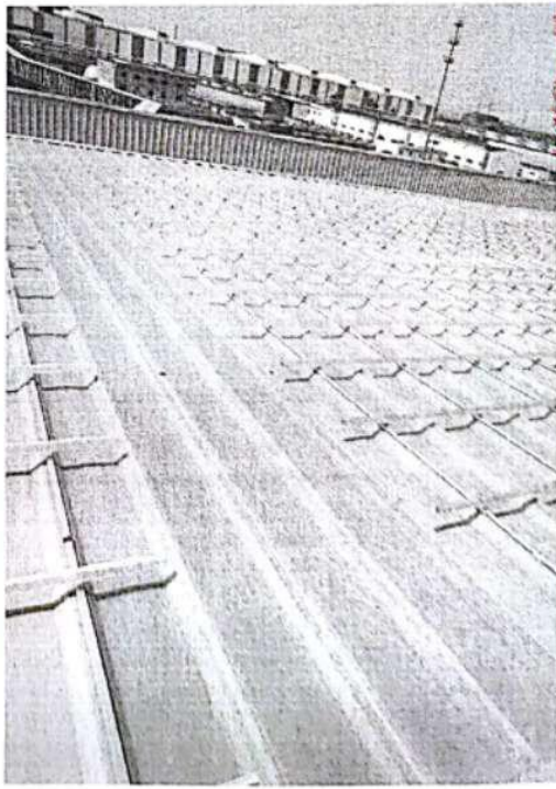
问题四：安装完成夹具、导轨的区域 采光带上安全网被拆除
