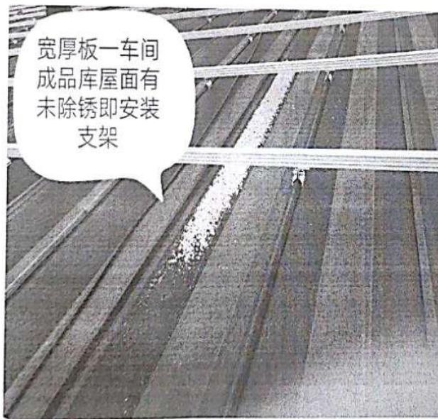
问题三：在未除锈的情况下安装夹具、支架
