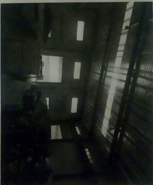
施工重点部位全覆盖
