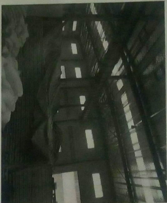
施工重点部位全覆盖
